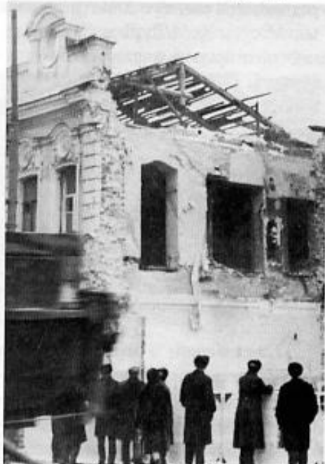
Снос здания Библиотеки, 1972 г.
